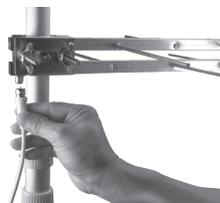
Подключите кабель к разъему антенны и закрепите кабель. Установите водонепроницаемый колпачок, защищающий соединение, чтобы избежать попадания воды.
